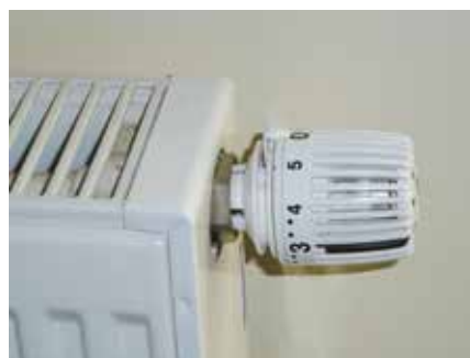
Bild 3-28: Ausnahme: Bei Ventilen und Absperrvorrichtungen bedeutet Drehen nach rechts „Drosseln“
