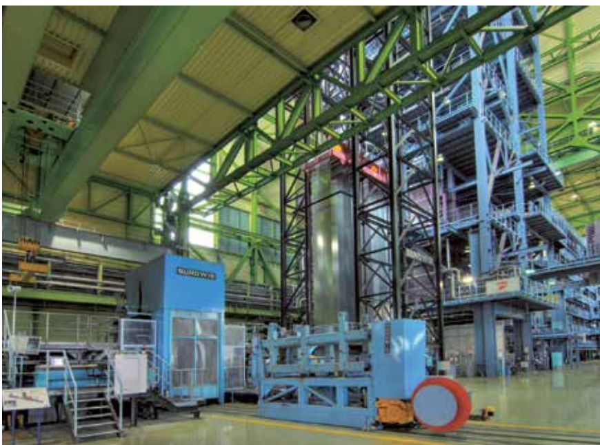
Bild 4-18: Beispiel für die Farbgestaltung der Feuerbeschichtungsanlage FB8 in Duisburg gestaltet durch das Studio von Garnier
